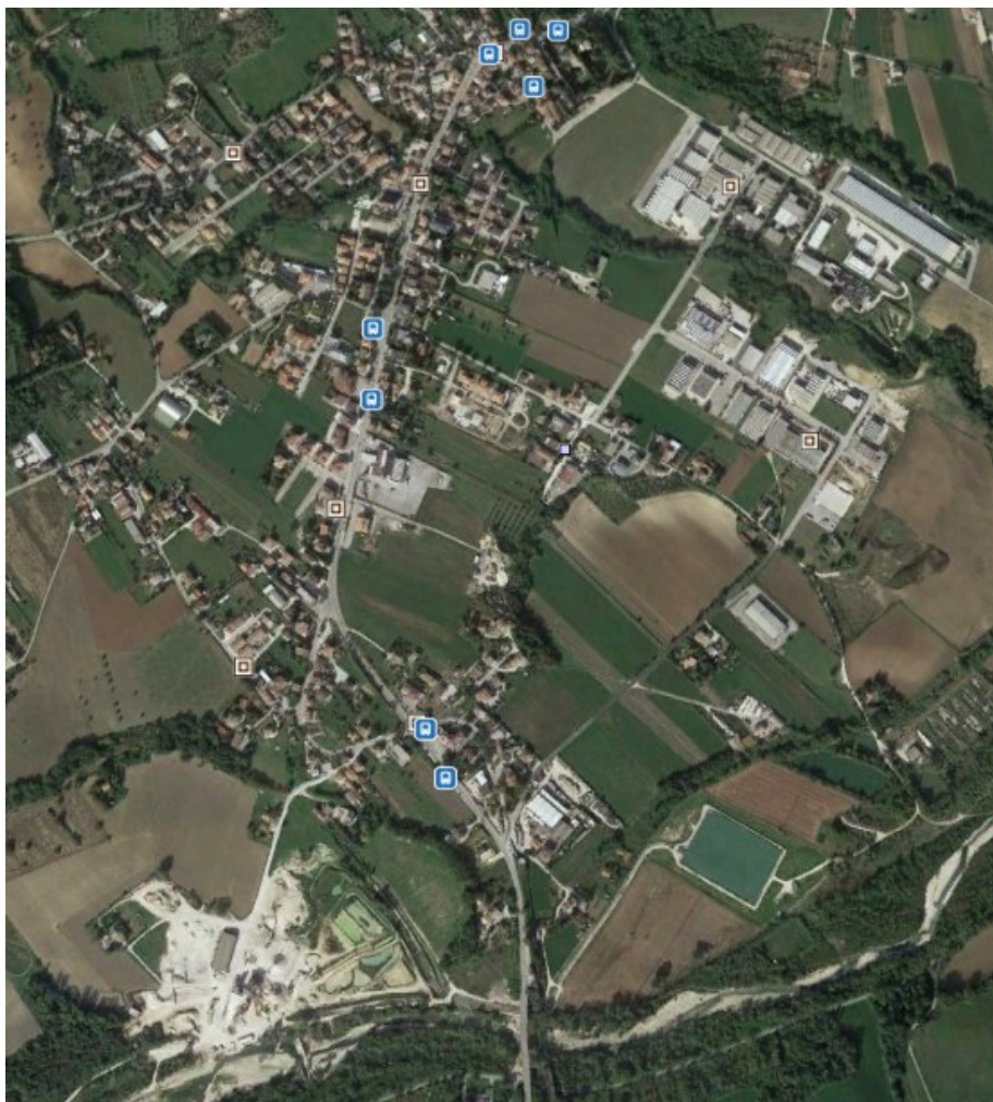
Fig. 2–stralcio foto aerea da Google – vista della frazione di Pian di Falerone
